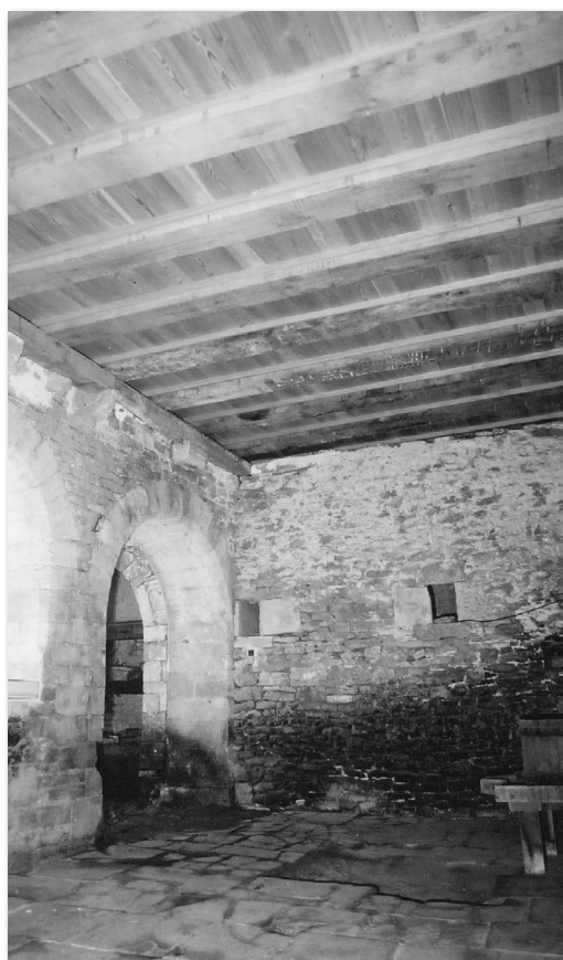
Galerie XV e siècle - après les travaux
