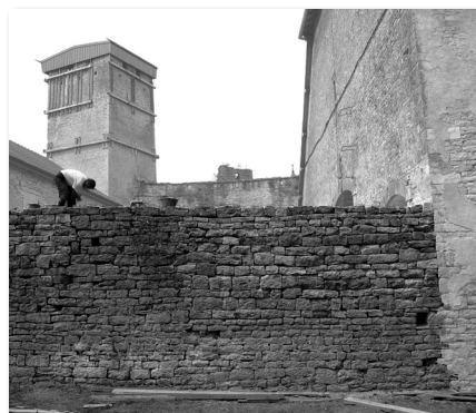
À la fin des travaux
