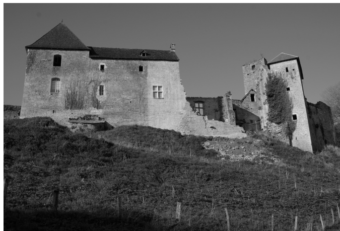
Façade nord, Mai 2017 : travaux de confortation terminés
