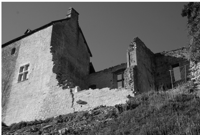
Consolidation de la courtine dans le logis Rolin
