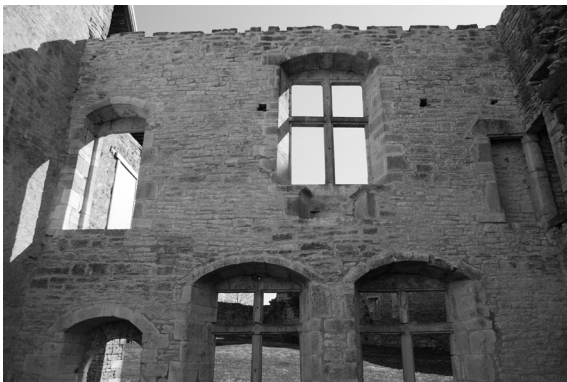
Parement intérieur, joints terminés
