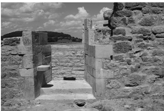
Restitution de la fenêtre de la cuisine dans la courtine
