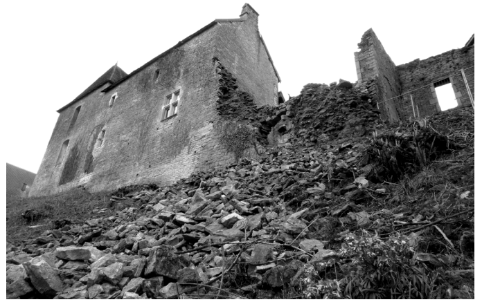
Logis Rolin : façade nord. janvier 2013 Juste après l'effondrement de la courtine
