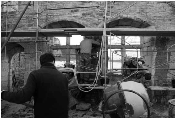
Mise en oeuvre des joints sur le parement intérieur
