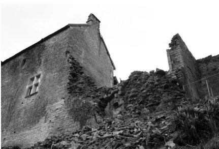
Ci-dessus : logis Rolin, façade nord en 2012
