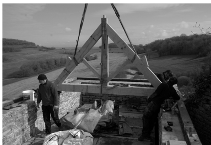
Logis nord : charpente Pose de la première ferme.
