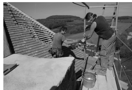
Logis nord : couverture Coupe de tuiles à l'approche des arêtières.
