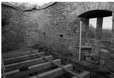
Logis nord : dernier niveau Pose des poutres du plancher. À droite : baie géminée restaurée avec coussièges.
