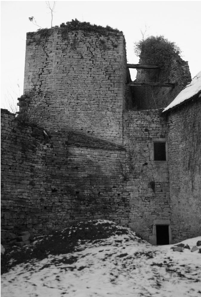
Logis nord : façade côté haute cour (2009)
