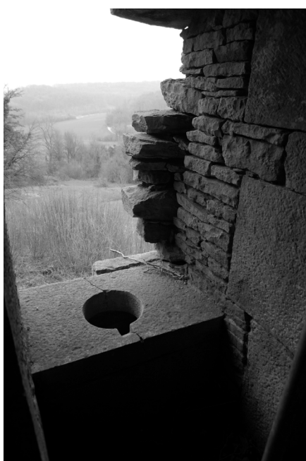
Logis nord : latrines du rez-de-chaussée dans l'épaisseur du mur nord-ouest
