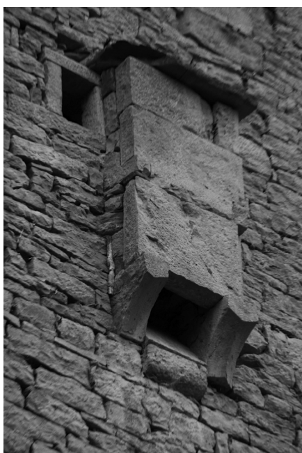
Logis nord : latrines du 1 er étage sur la façade nord-ouest
