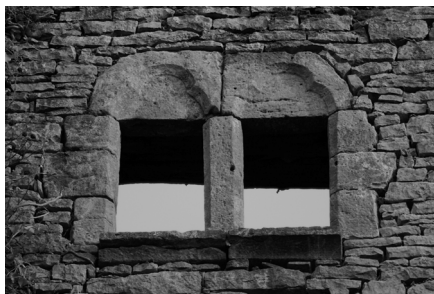
Logis nord : baie géminée au dernier niveau du bâtiment, sur la façade nord-ouest
