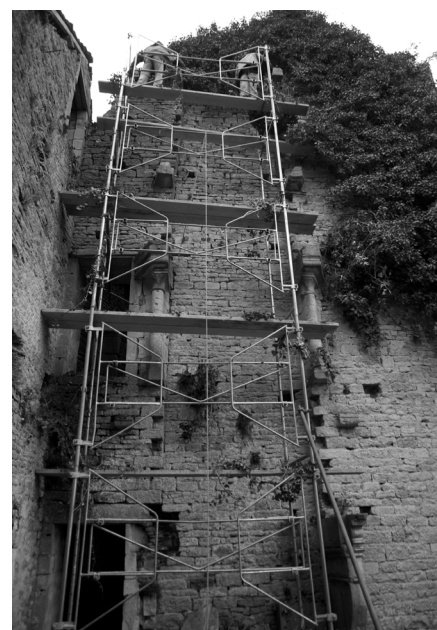
Chantier de janvier : Enlèvement du lierre sur le logis nord
