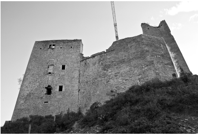
Courtine nord-ouest, côté fossés, après travaux (2012)
