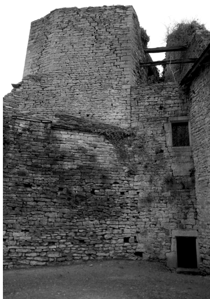
Logis nord, côté haute cour
