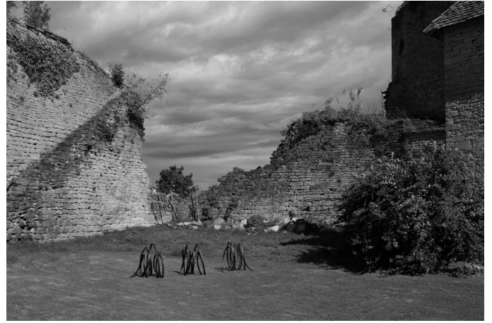
Courtine nord-ouest, côté haute cour, avant travaux (2010)
