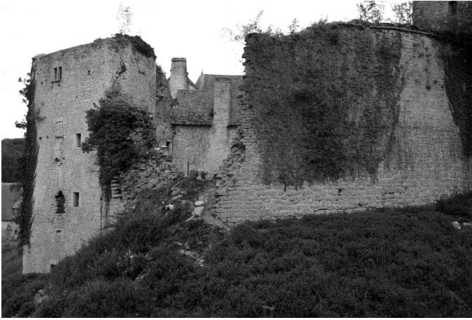
Courtine nord-ouest, côté fossés, avant travaux (2010)
