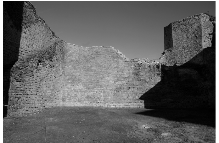
Courtine nord-ouest, côté haute cour, après travaux (2012)
