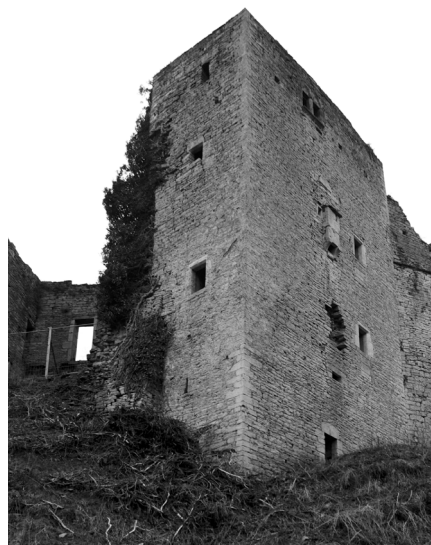
Logis nord, côté fossés, après nettoyage de la façade
