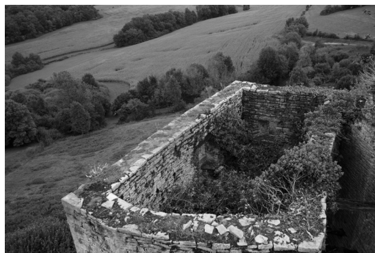
Logis nord : maçonneries à stabiliser avant pose d'une charpente
