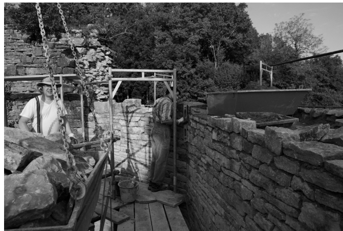
Réhabilitation de la courtine nord-ouest par la SARL Bruno GÉRARD
