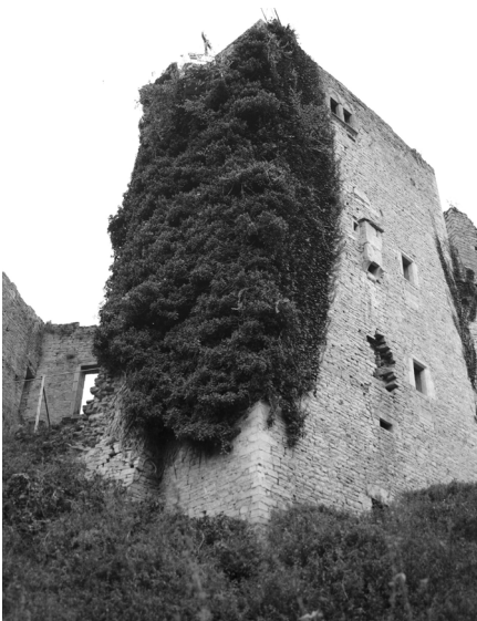
Logis nord, côté fossés, avant nettoyage de la façade
