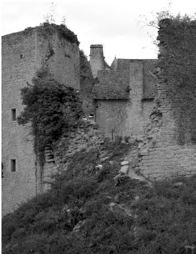
Courtine nord-ouest (côté fossés) avant travaux
