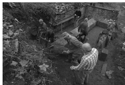
Chantier associatif : déblaiement d'une fontaine communale
