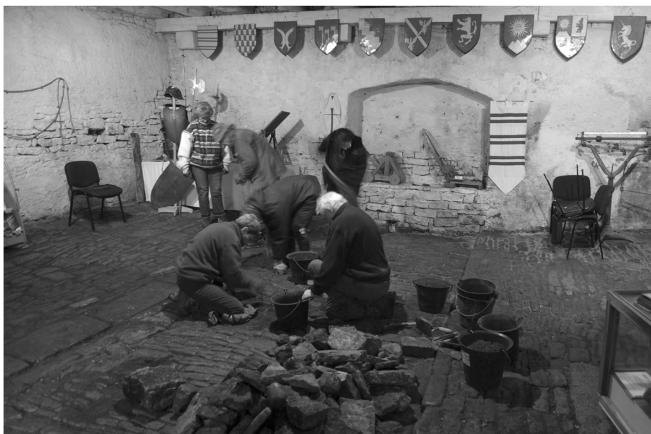
Chantier du 4 décembre : remplacement de pavés dans les anciennes écuries
