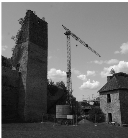
Début du chantier de restauration de la courtine entre la tour du fond et le logis nord
