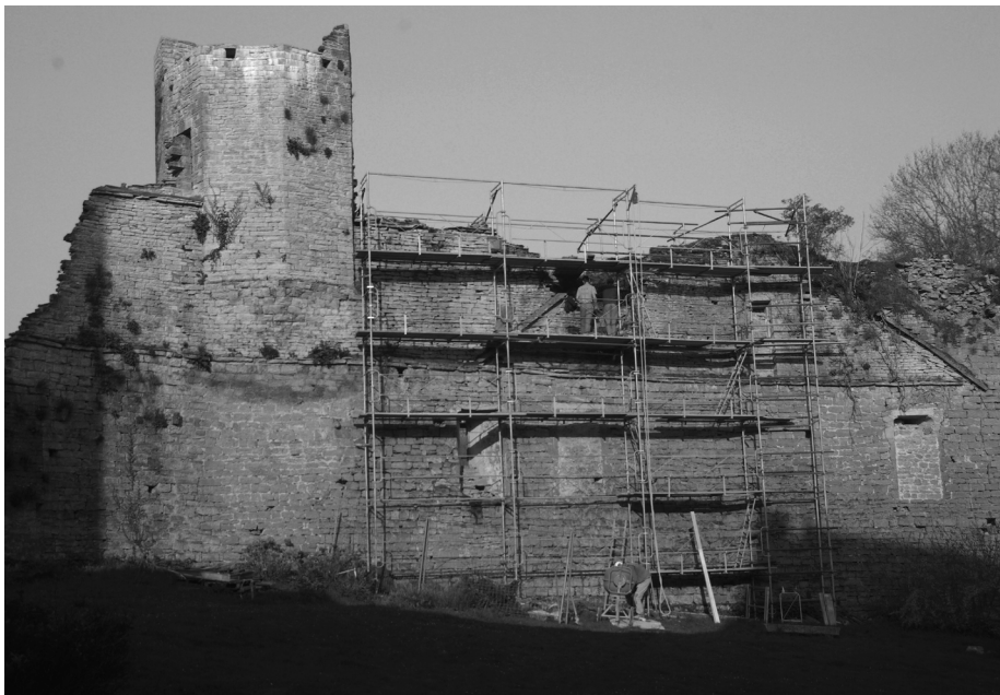
Chantier de la courtine, côté haute cour
