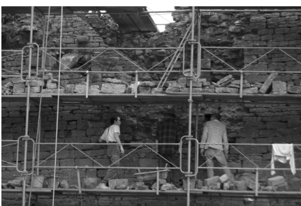
Chantier de la courtine, côté fossé Purge du parement sur environ 5m de hauteur
