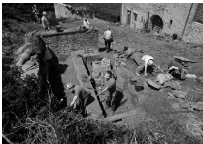
Mise en valeur de l'ancienne fontaine communale, en contrebas du château
