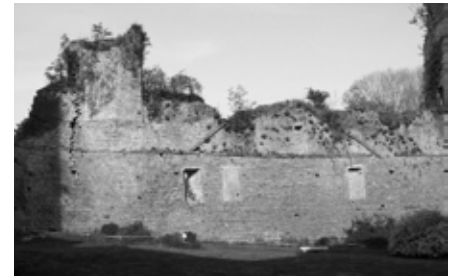
Courtine sud-ouest avant travaux (2006)
