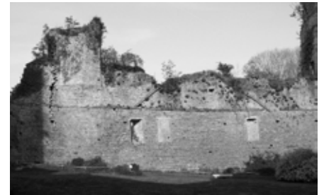
Courtine sud-ouest avant travaux (2006)
