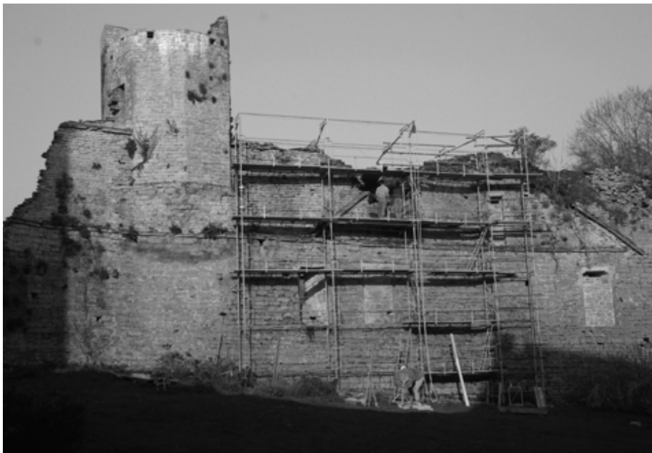
Chantier de la courtine, côté haute cour
