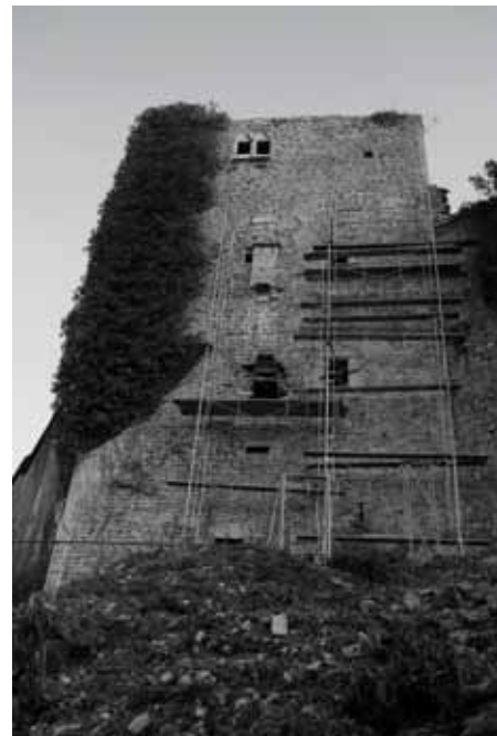
2008 | Logis Nord Dégagement de la façade
