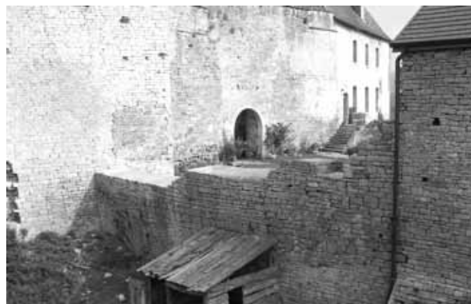
2007 | Mur nord-est de la basse cour Restauration
