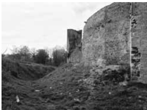
2003-2005 | Fossés Débroussaillage et clôture
