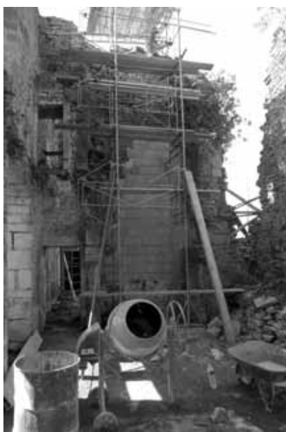
2006-2009 | Bâtiment Rolin Dégagement et consolidation
