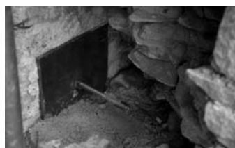
Coté cour, platine et extrémité tirant, avant reprise maçonnerie
