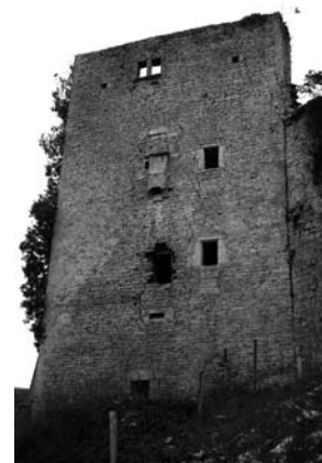
Logis nord, après enlèvement du lierre
