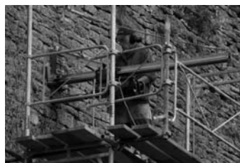
Carottage pour la pose des tirants, coté nord
