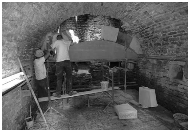
Restitution de la voûte du four
