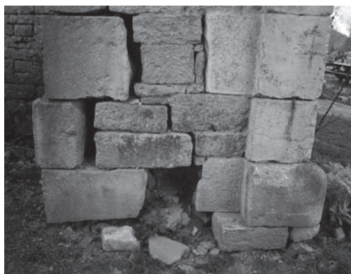
Jambage du portail avant les travaux ▲
