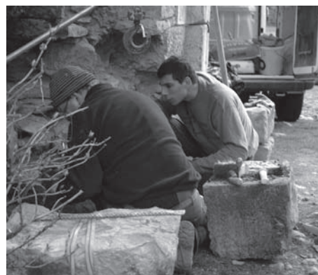
Remise en place du jambage ▲
