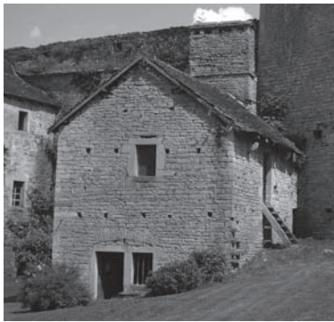
◀ Four seigneurial Réfection de la charpente et couverture en juillet 2008
